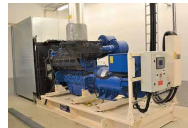
Nødstrømsagregat for beredskap.
