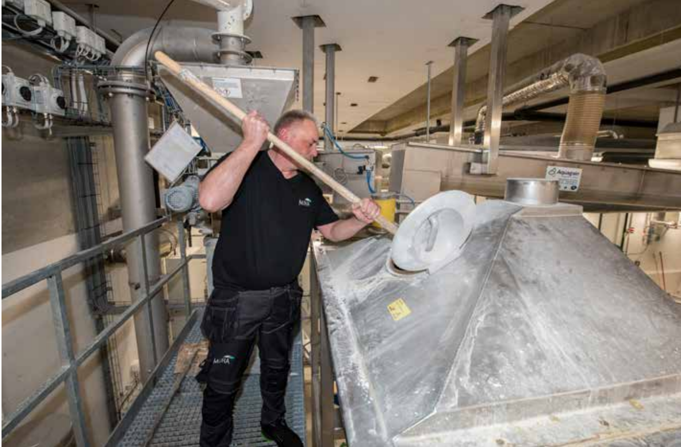
Rengjøring av slam/kalkmikser.
