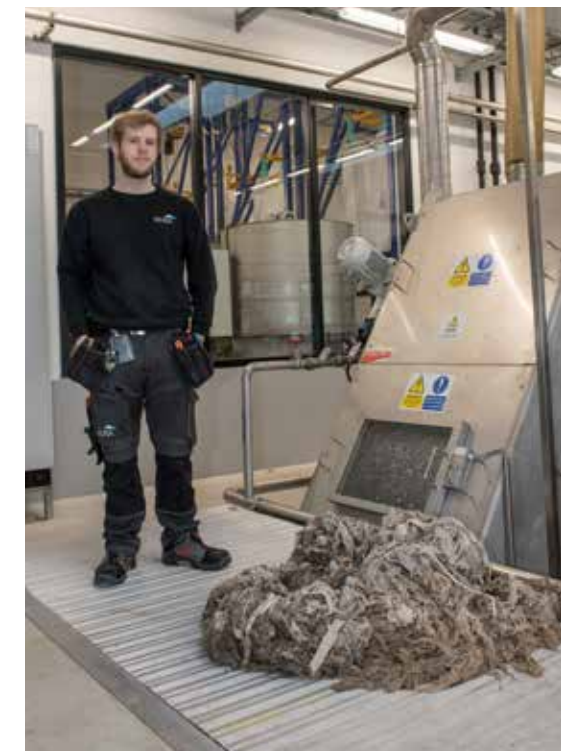
Fyller og avfall som kastes i avløpet tas ut av avløpsristene til Tangen RA.
